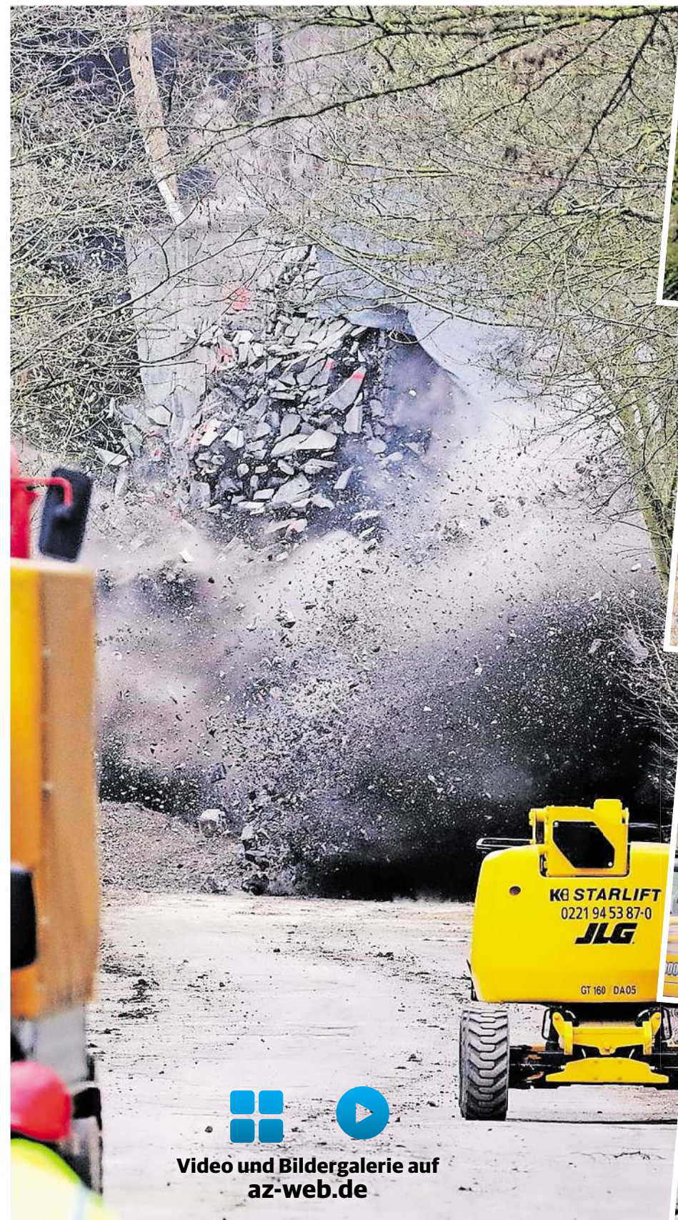
Um 10.43 Uhr wird das Rüstbach-Viadukt gesprengt. Übrig bleibt ein Berg aus Steinen und Stahl, den Bagger beseitigen. FOTOS: JÜRGEN LANGE, PETER KAMRATH
